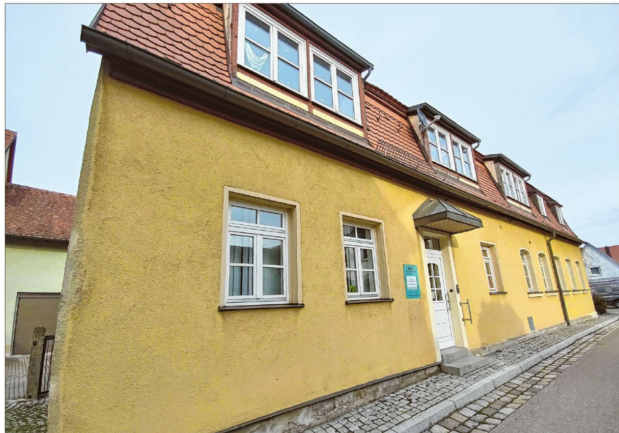
In diesem Gebäude an der Grünen Baumgasse in Burgbernheim könnte bald das städtische Archiv eine neue Bleibe finden. Foto: Katrin Merklein
